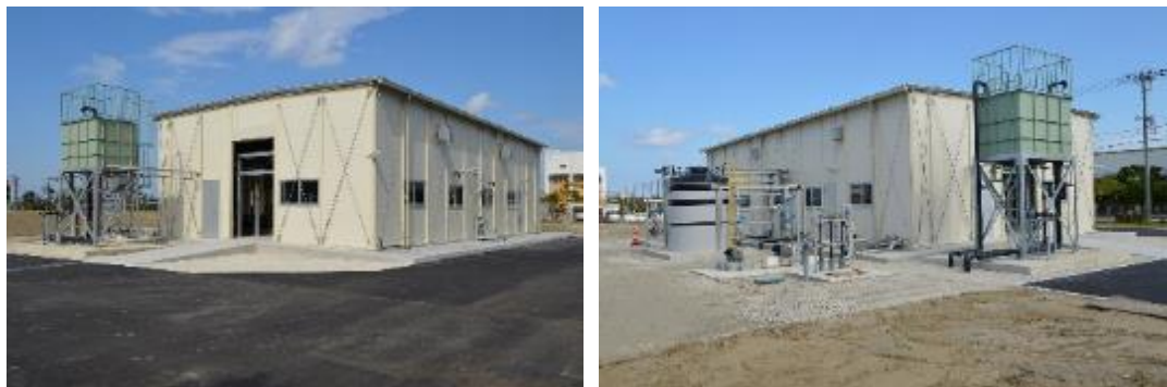
右：パイロットプラント正面
