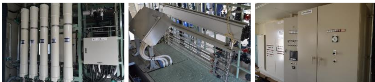
左：UF 膜ユニットの様子 中：UV 消毒機器の様子 右：プラント内はすべて電気で制御される 出所) 筆者撮影
